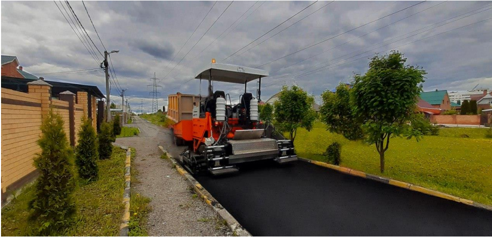
Гусеничный асфальтоукладчик АСФ-Г-3-01 в работе
