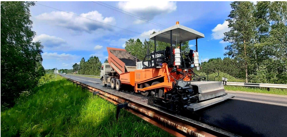
Колесный асфальтоукладчик АСФ-К-4-02-2 в работе
