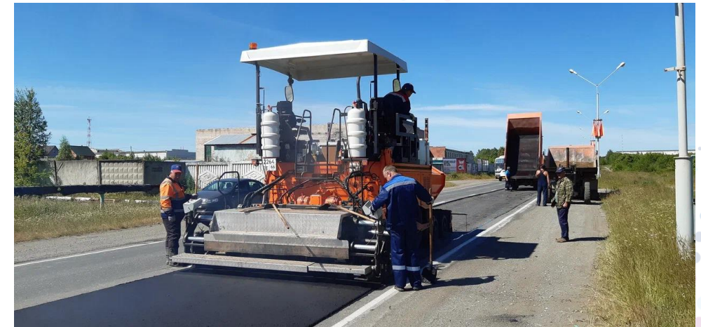
Колесный асфальтоукладчик АСФ-К-4-02-2 в работе
