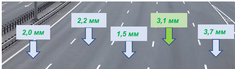
Результаты измерения колейности на участке ЩМА-16 сера (06.10.2021)
