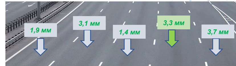
Результаты измерения колейности на участке ЩМА-22 (06.10.2021)
