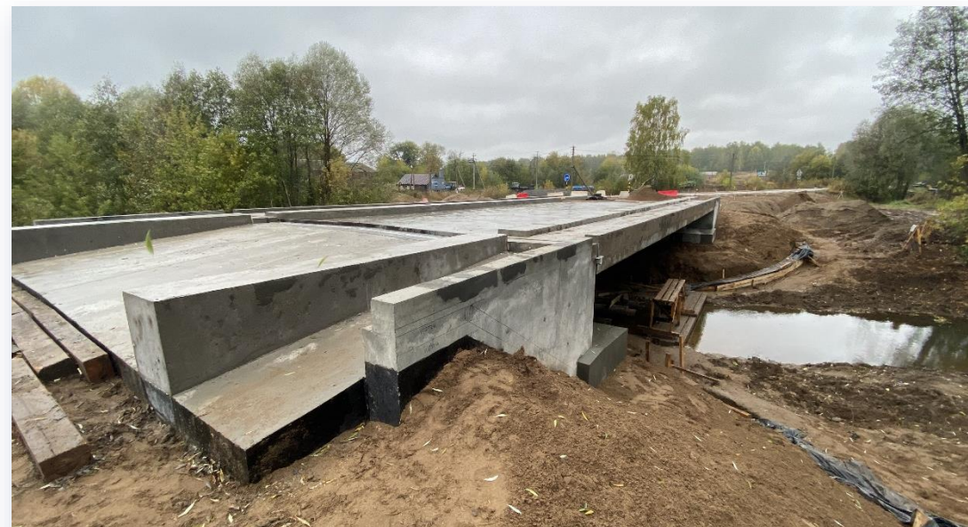
В процессе реконструкции
