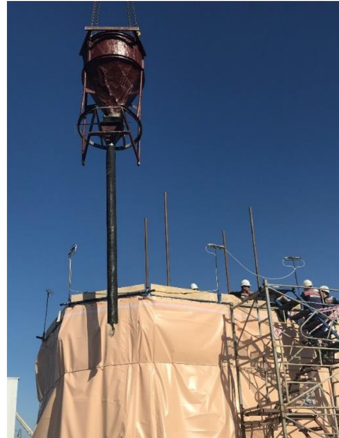
Подача бетонной смеси слоями 18-20 см
