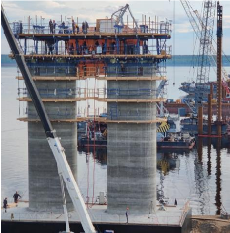
Скользящая опалубка с подвесными подмостями
