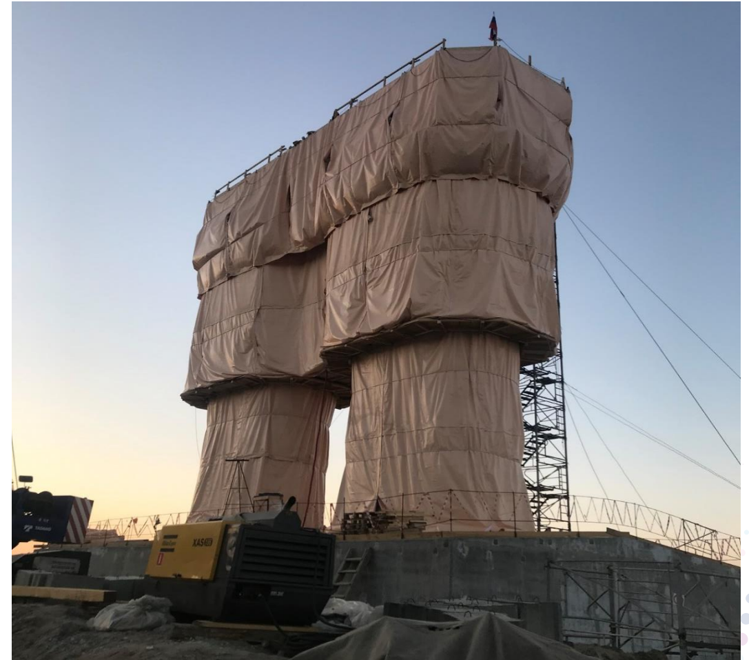
Скользящая опалубка в технологическом укрытии
