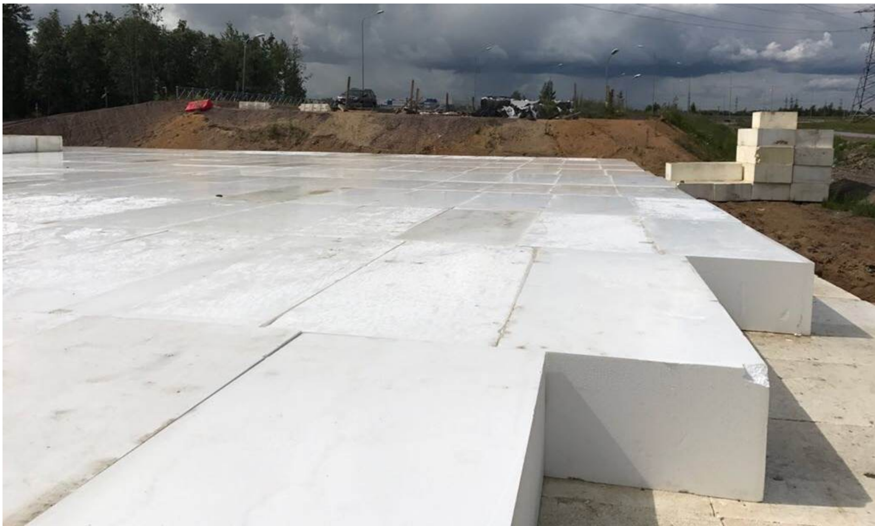
Укладка второго слоя блоков в насыпь
