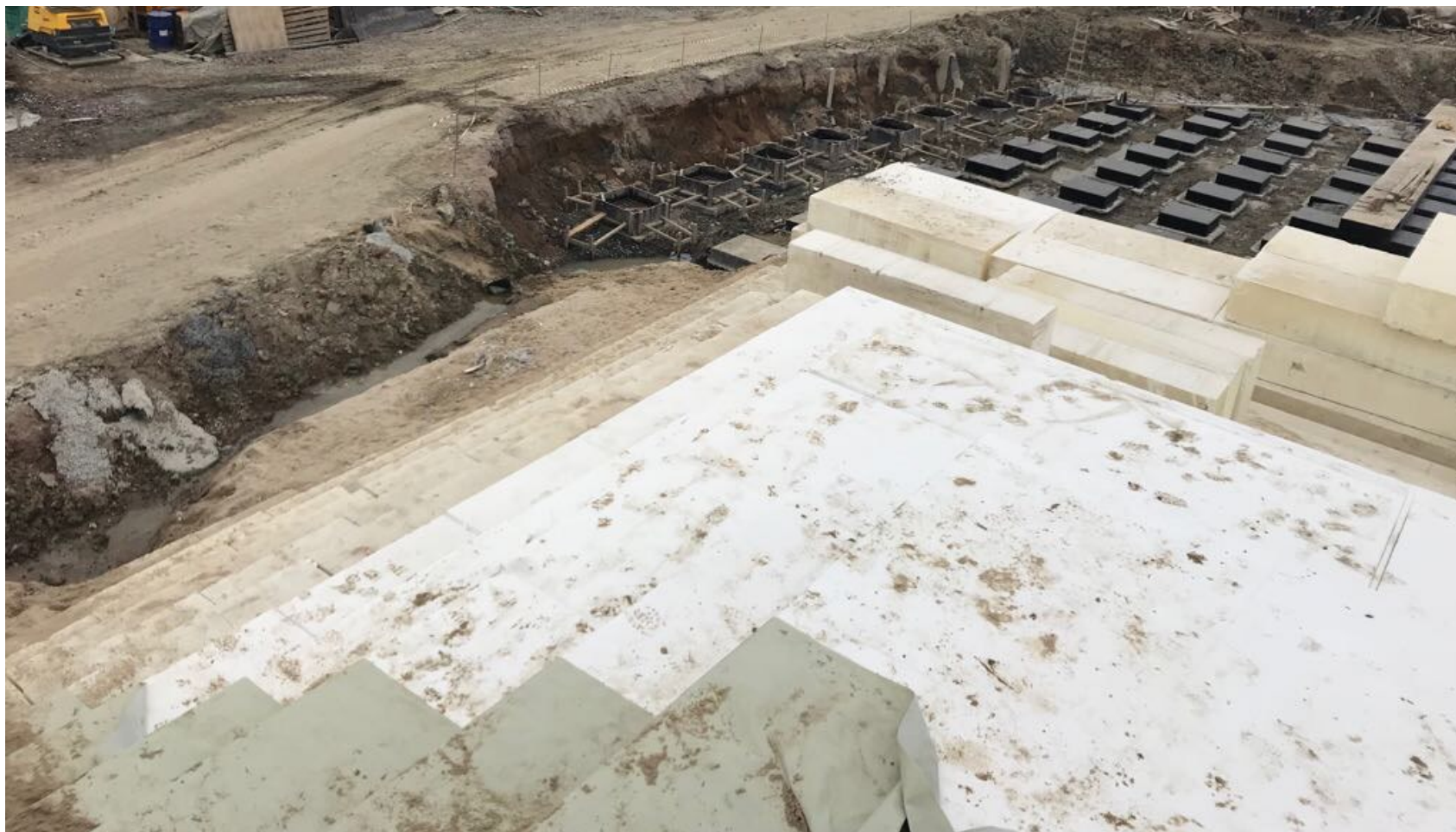
Примыкание легкого ядра насыпи к свайному полю перед устоем путепровода
