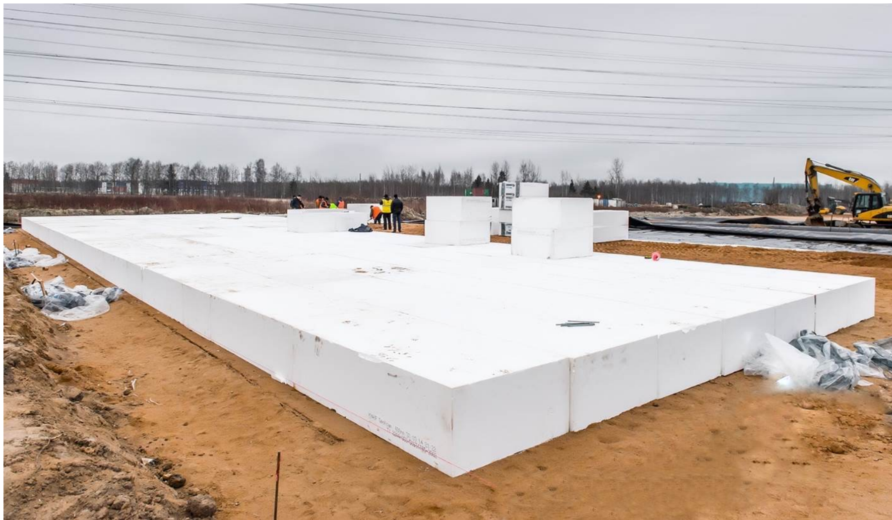
Укладка нижнего слоя блоков в насыпь
