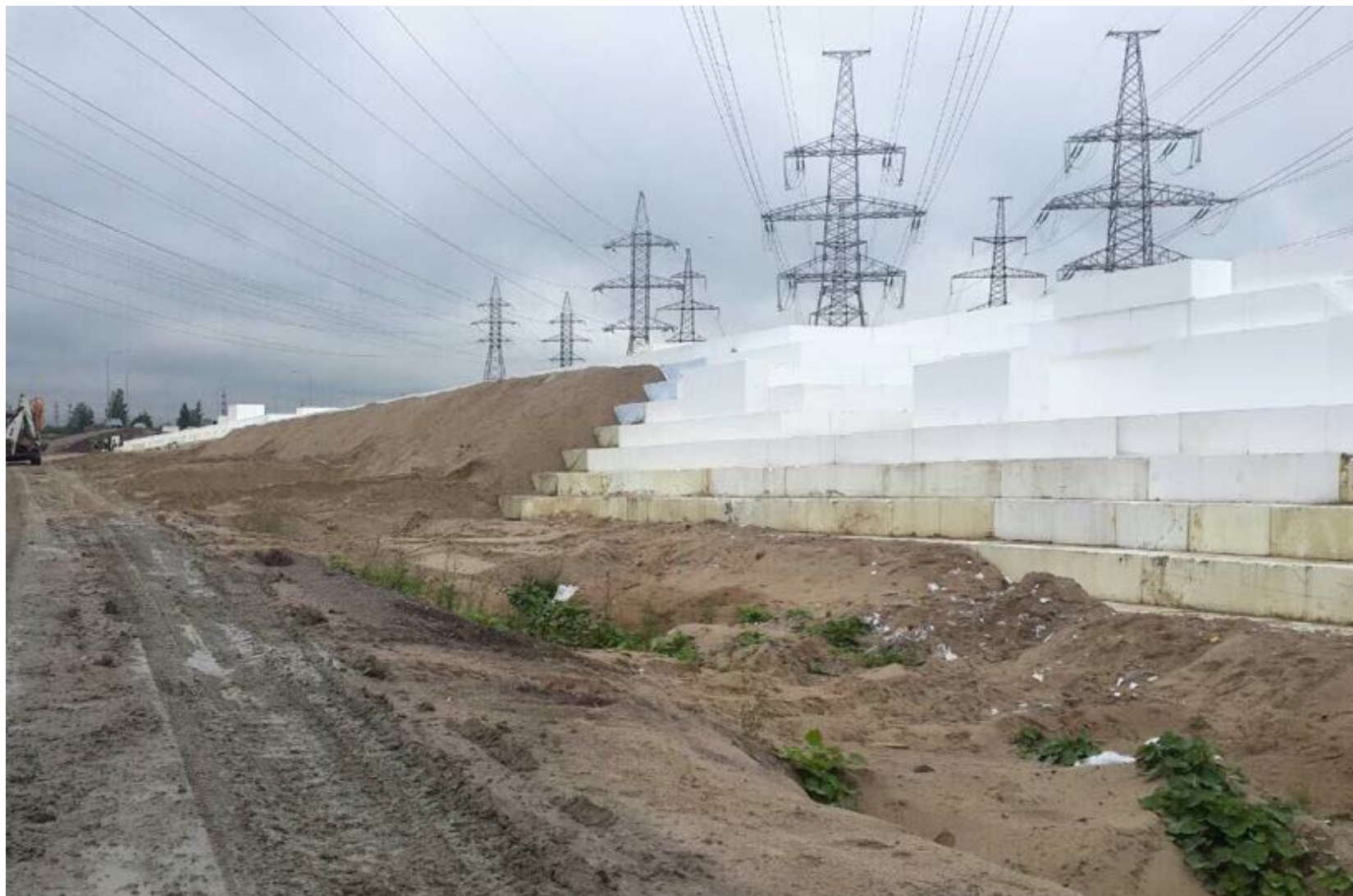
Устройство защитного слоя грунта на откосах насыпи
