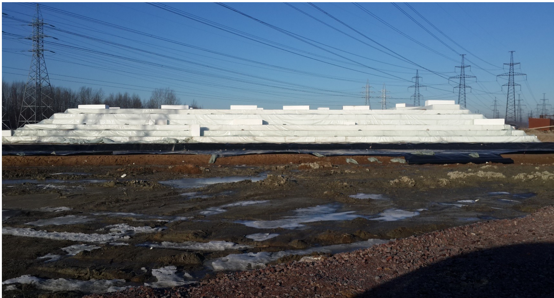
Легкое ядро насыпи, сложенное из блоков перед отсыпкой грунта на откосы
