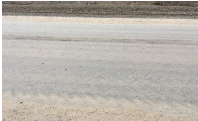
Основание, регенерированное с комплексным минеральным вяжущим
