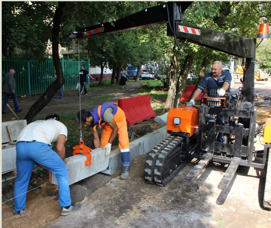
Укладка гранитного бордюрного камня установкой МБМ-250
