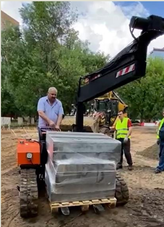
Транспортировка бордюрного камня установкой МБМ-250
