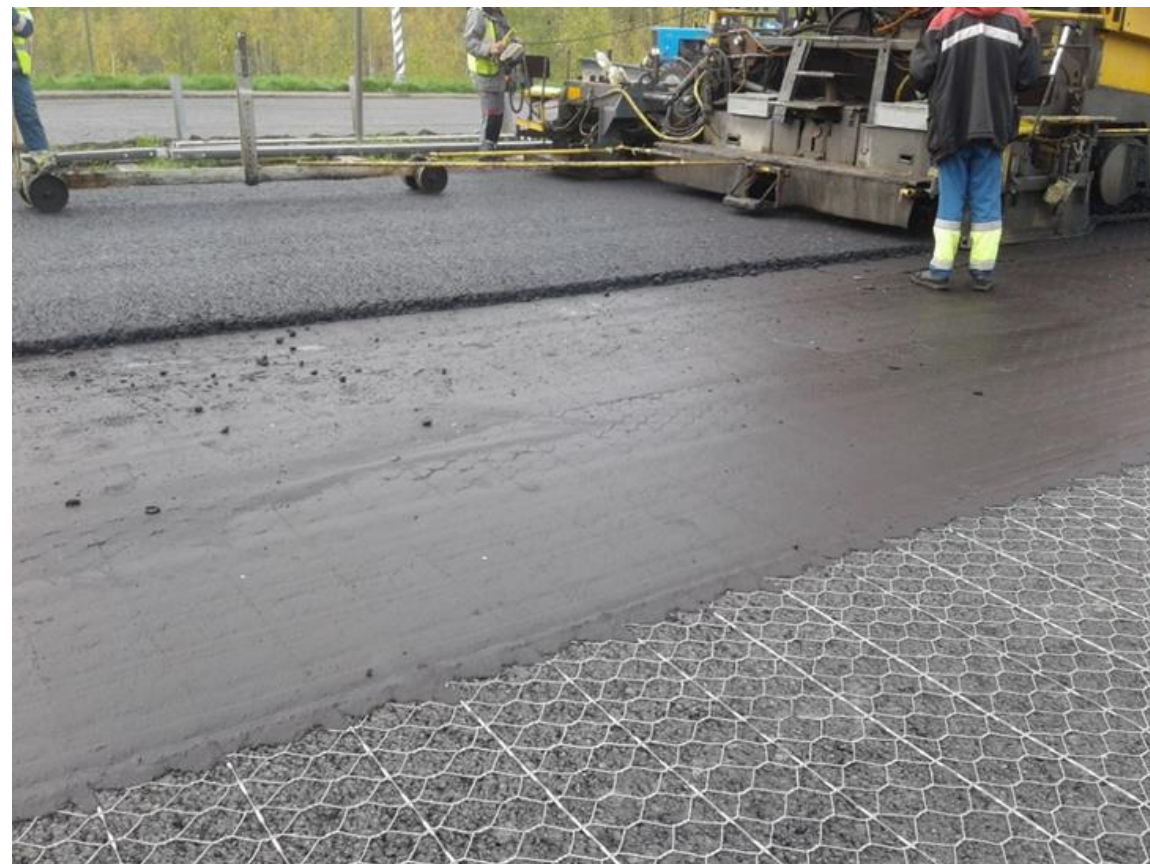
Укладка горячей асфальтобетонной смеси по слою ЛЭМС
