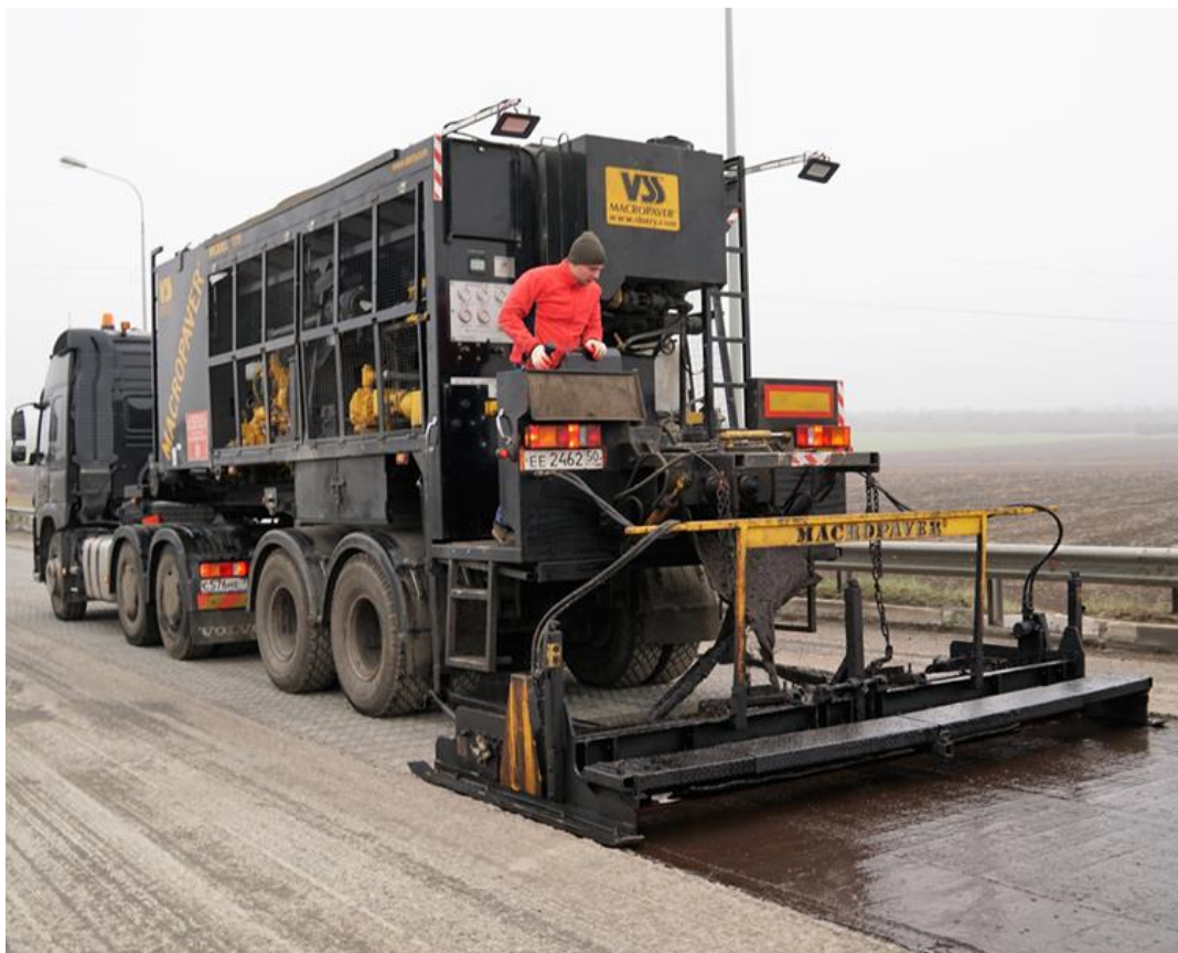
Распределение тонкого слоя ЛЭМС по стальной сетке
